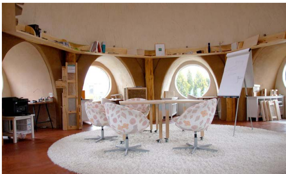
Interiér samonosnej slamenej kupoly, ateliér Createrra v Hrubom Šúre. Na stenách sú použité hlinené omietky, podlaha je tiež hlinená. V interiéri dominuje masívne drevo.
